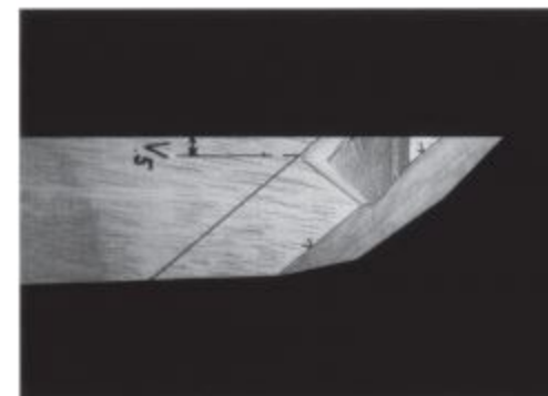
Die ausgearbeitete Firstpfettenkerve: Unterseite Im Vergleich mit Seite 33 erkennen wir das kleine Auflager.
